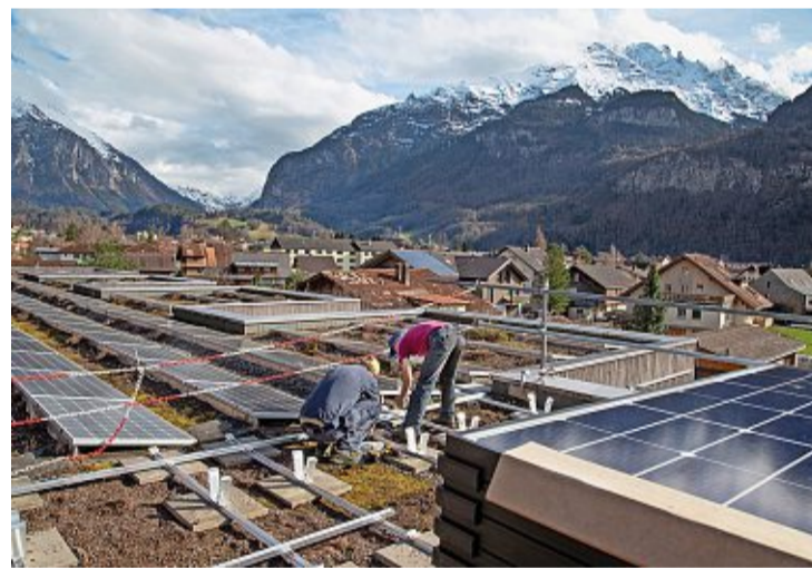
Auf Dächern des Meiringer Sunneschyn werden Solarpanels installiert.
