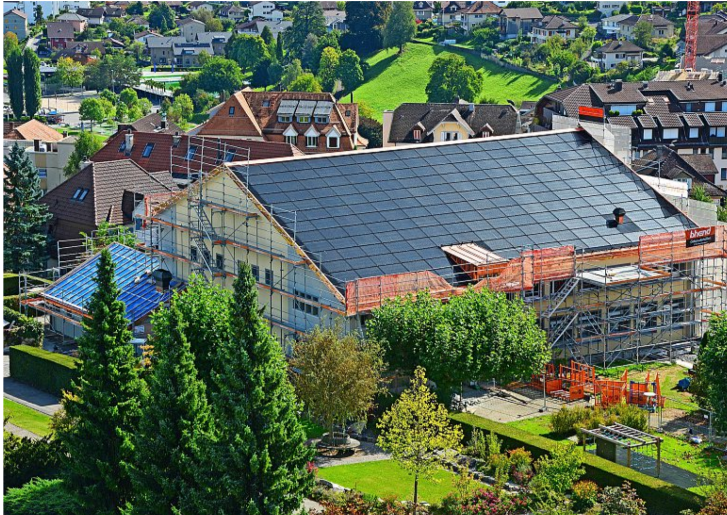
Der Solarstromanteil am Gesamtstromverbrauch ist in Spiez vergleichsweise hoch. Hier wird auf dem Dach des Kirchgemeindehauses Spiez eine Indachanlage montiert. Fotos: PD
