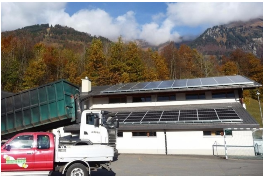
Die Fotovoltaikanlage liefert Strom vom Turnhallendach – der Transporteur die Schnitzel für die Holzheizung. Bild: Beat Jordi
